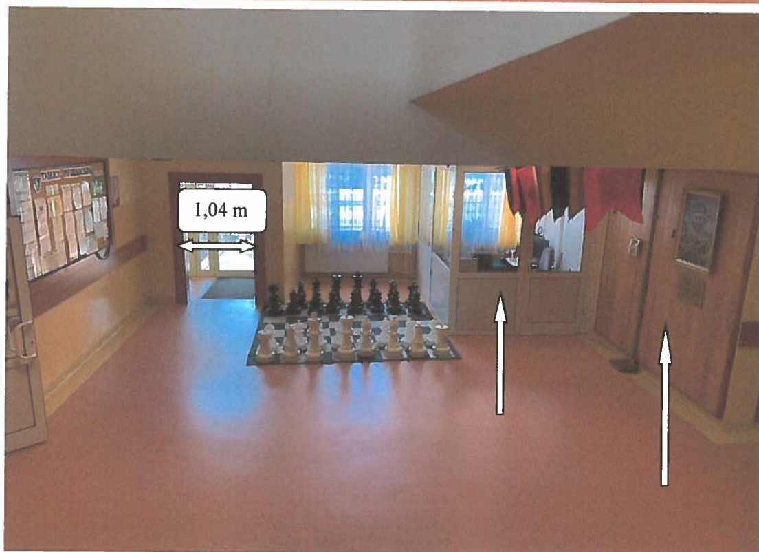
Widok wyjścia z klatki schodowej K1, przez hol pełniący funkcje uzupełniające – zabudowa pomieszczenia portierni z konstrukcji wykonanej z tworzywa sztucznego oraz drewniana okładzina na fragmencie ściany
