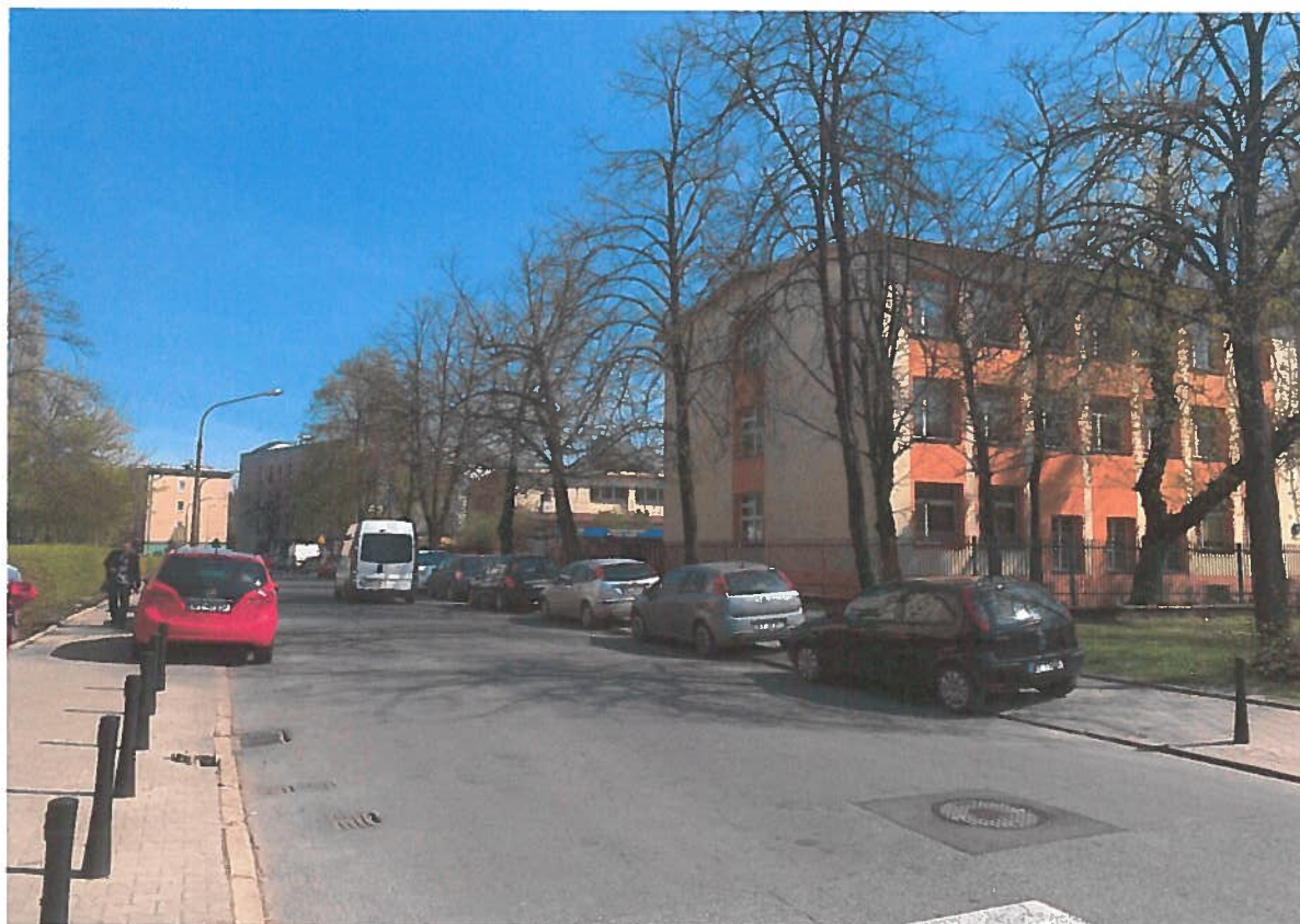
Widok budynku wzdłuż ul. Żytnej – drzewa utrudniające dostęp do elewacji
