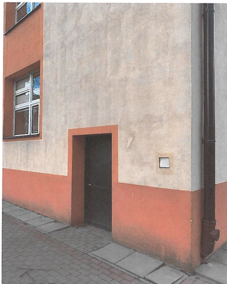
Widok wyjścia z klatki schodowej K2 – na poziomie parteru
